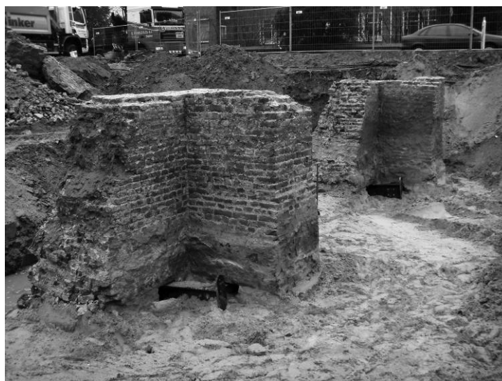
Afbeelding 37 (boven): aanzicht van de spitsboogfunderingen (steunberen) vlak voor transport.
